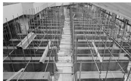
特定天井耐震対策工事（足場組立工事）
