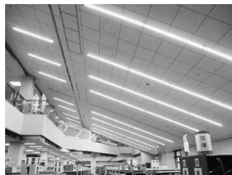
耐震対策工事後の天井
